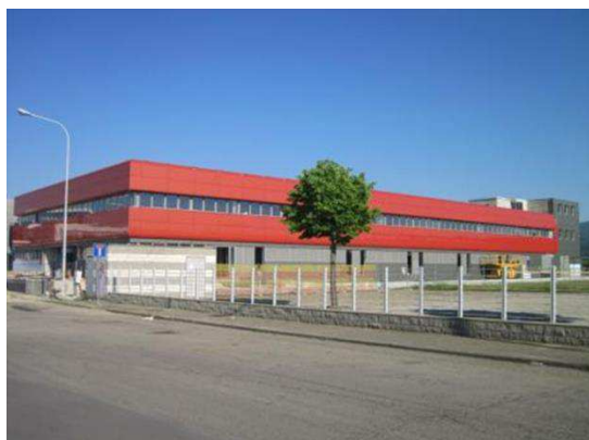
Figura 5: Immagine esterna del Datacenter
