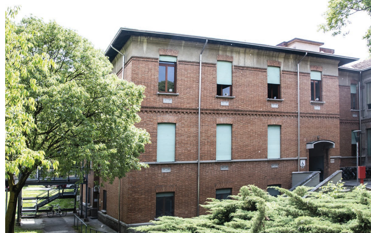
Il Centro Servizi, all'ospedale di Mantova
